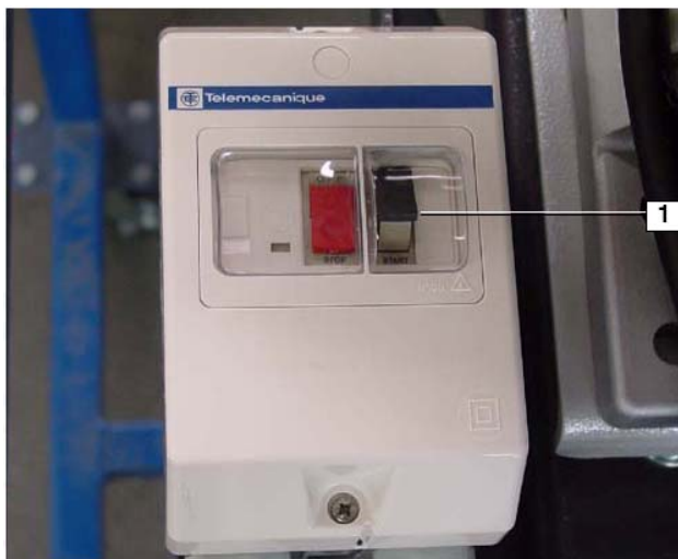
Рис.12. Контактная коробка с автоматом защиты электродвигателя
